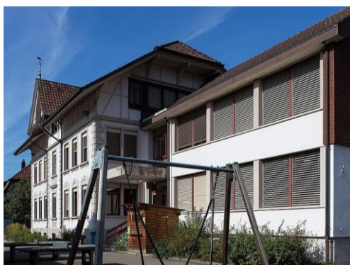
Abbildung 8-2: Schulhaus Zäziwil mit Anbau aus dem Jahre 1986. Foto: Roland Zumbühl
